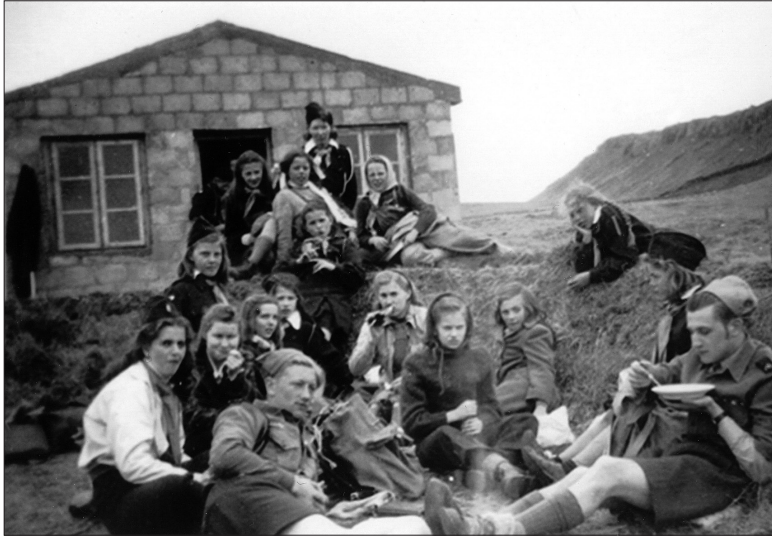
Valhöll í Vaðlaheiði í byggingu.
